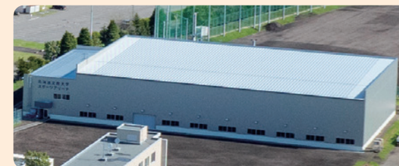
▲スポーツアリーナ 竣工
